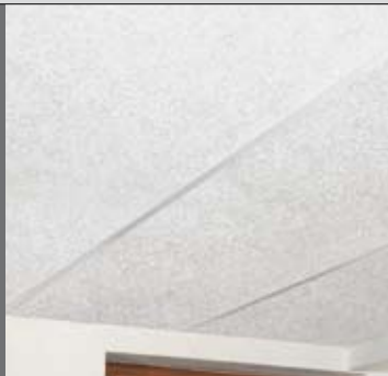
Fertige Deckenansicht gleicht damit der Schienenmontage
