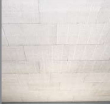
Deckendämmung mit Topdec Smartline (attraktive Optik durch Schattenfuge, vorteilhaft für Tiefgaragen)
