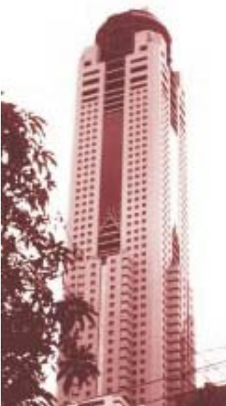
Blaze-Shield II wurde für den Schutz des Baustahls des Bayok Towers in Bangkok verwendet
